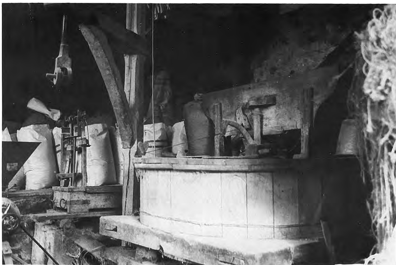
Le moulin avec la potence pour lever les meules lorsqu'on procède au rhabillage.
