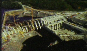
Centrale hydroélectrique de Grand-Mère, Québec
