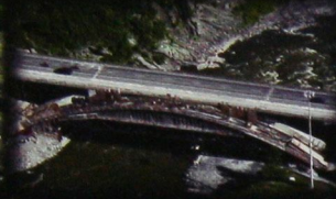
Pont de la rivière Chaudière, Lévis
