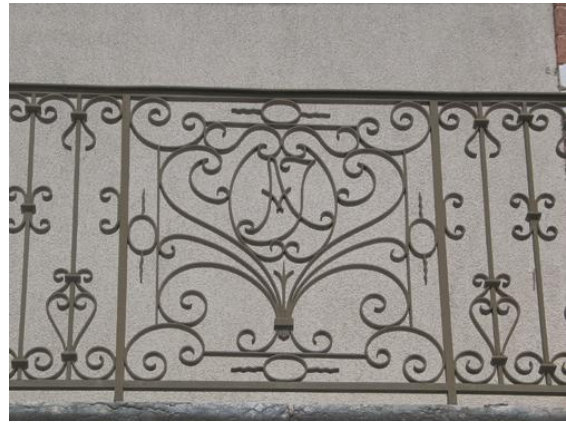
Détail d'un garde-corps de balcon avec initiales centrales – les Buisnières
