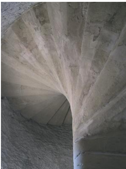
Escalier en vis en molasse de la maison dite « la Vigie » – le Bourg
