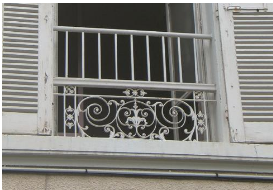
Garde-corps en fonte moulée rehaussé a posteriori – Gachetière
