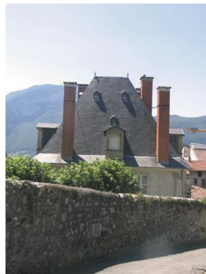
Toit à quatre pans couvrant le « château de Siéyès » – Veronnière
