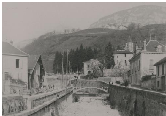
Ancienne passerelle sur la Roize / collection Musée Dauphinois
