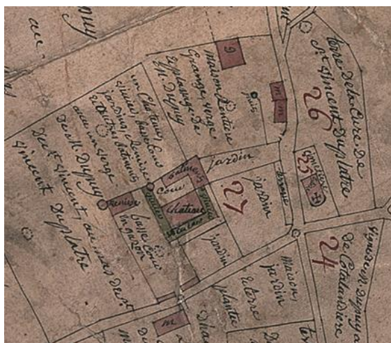
Eglise Saint-Vincent (parcelle 25) et « château de Saint-Vincent » (parcelle 27) – Atlas de Dupuy
