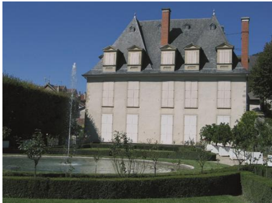
Façade sud du Château de Siéyès et son jardin classique – Veronnière
