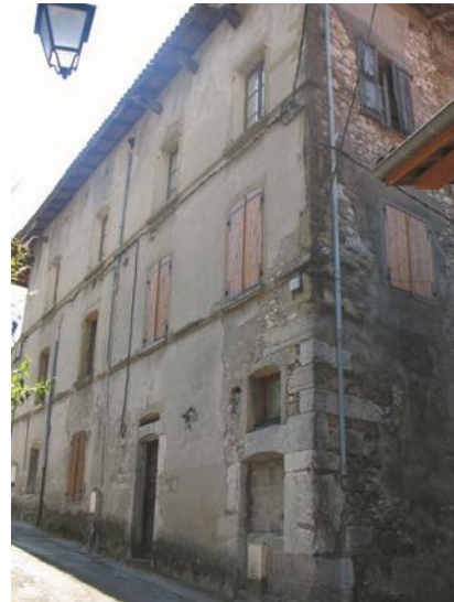
Double cordon filant servant d'appui – le Bourg
