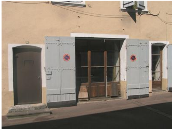
Ouvertures du 18 ème s. et baie de boutique du 19 ème s./début du 20 ème s.
