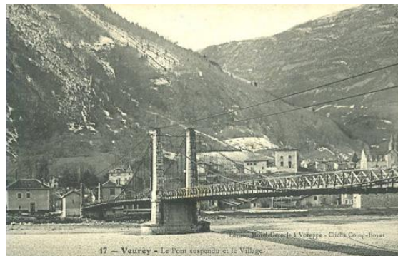
Ancienne carte postale du pont suspendu dit « de Veurey » avant reconstruction en 1932
