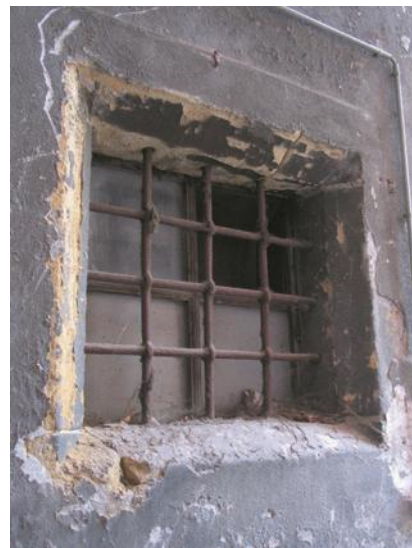
Détail d'un barreaudage ancien en fers emboîtés
