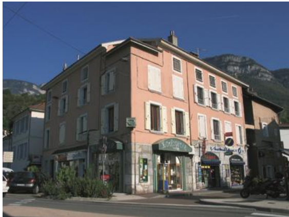
Baies de boutique du 19 ème s. en anse de panier en pierre de taille appareillée – le Bourg
