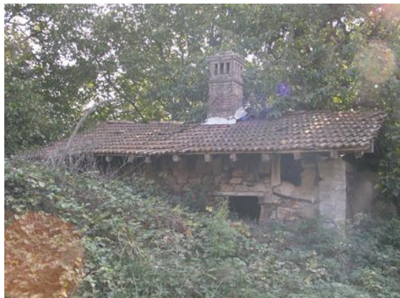
Four à pain doté d'une belle souche de cheminée– Mativières
