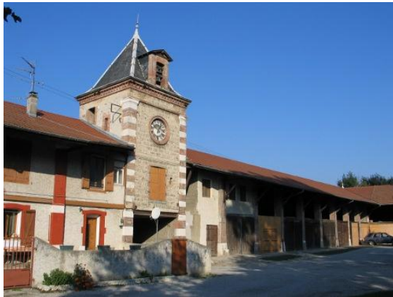
Aile ouest vue depuis la cour
