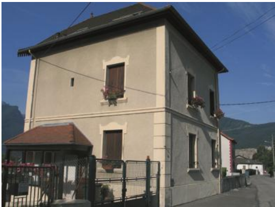
Décor en ciment moulé – le Boutet et Nardan
