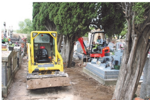
Cimetière : pose des autobloquants dans les allées
