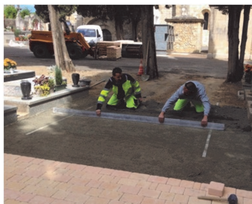
Cimetière : pose des autobloquants dans les allées
