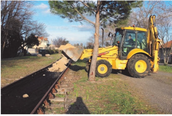
Voie verte : pose du revêtement
