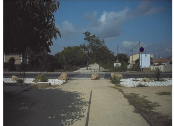
Voie verte terminée
