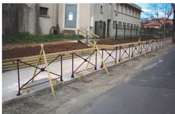
Chemin des écoliers : pose des protections
