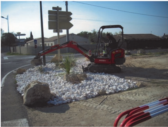
Pose des galets et enrochement
