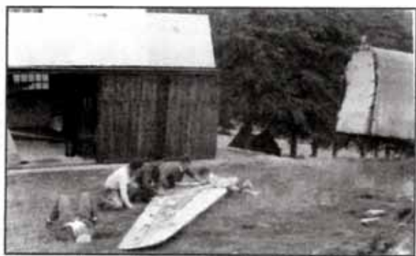
Travaux de grattage sur les ailes du Castel C-310p avant peinture.
