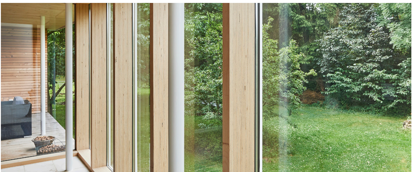
Jardin d'hiver composé de poutres en BauBuche Le jardin d'hiver avec vitrage sur toute la hauteur est fermé par une façade à montants-traverses. Architecte Ing. dipl. Michael Danke, Danke Architekten Construction bois Holzbau Stassny
