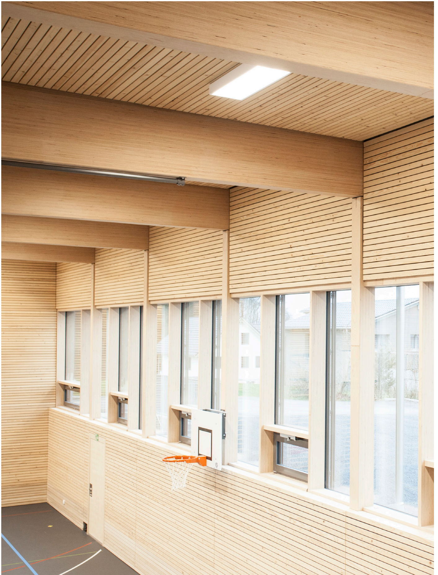
Nouveau gymnase, Islisberg Hauteur de poutres élancée avec une portée de 12,60 m et des dimensions de section de seulement 90 cm de haut et 20 cm de large. Architectes Langenegger Architekten AG, Muri Conception de l'ossature Makiol Wiederkehr AG, Beinwil am See Construction bois Max Vogelsang AG, Wohlen
