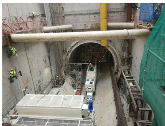
Tunnel à Gambetta © Haozhu Deng, 2019.
