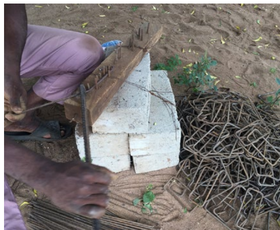
Pliage des barres d'armature à la main © Aroa Gonzalez Rodriguez, 2019.
