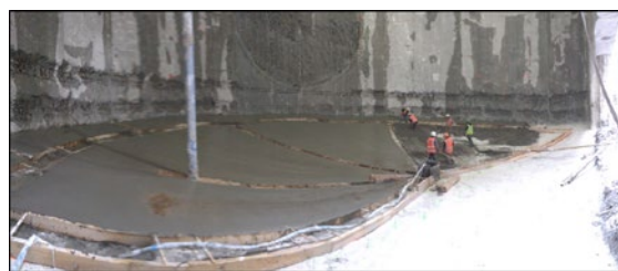
Réalisation du béton de propreté du radier de l'ouvrage OA-P13 © Khadija Ben Ammar.
