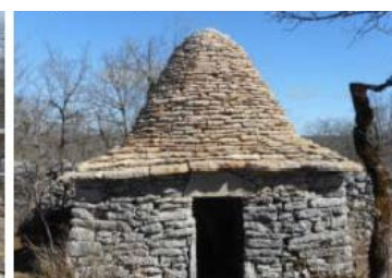
Le chantier terminé
