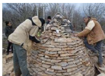
Reconstruction de la toiture
