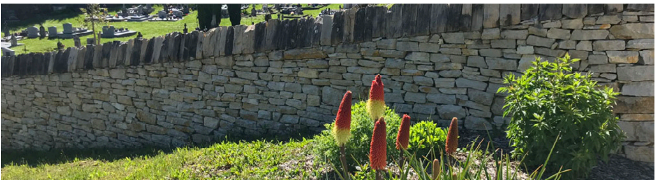
Mur en pierre sèche - Cimetière de Caniac du Causse - © F. Naudet
