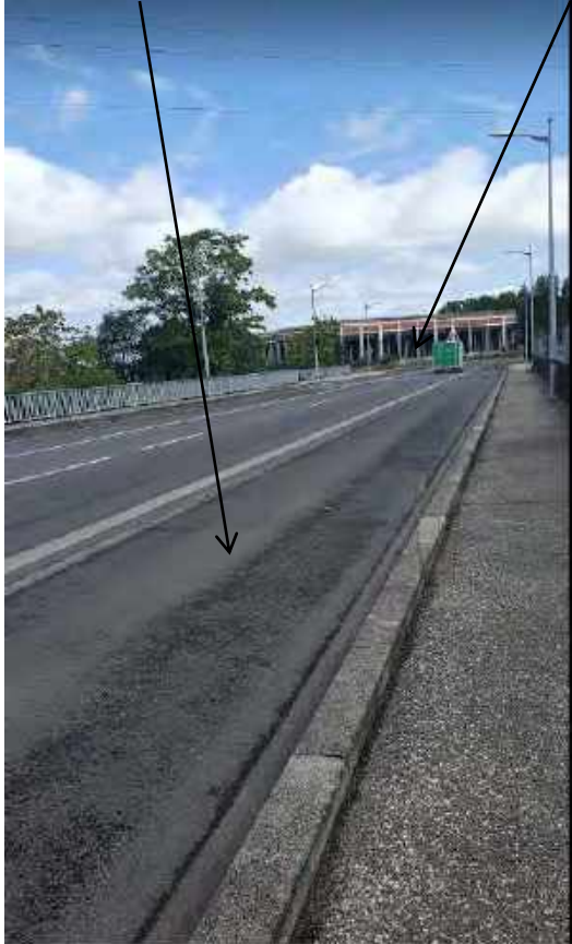
Pont existant qui sera aménagé
