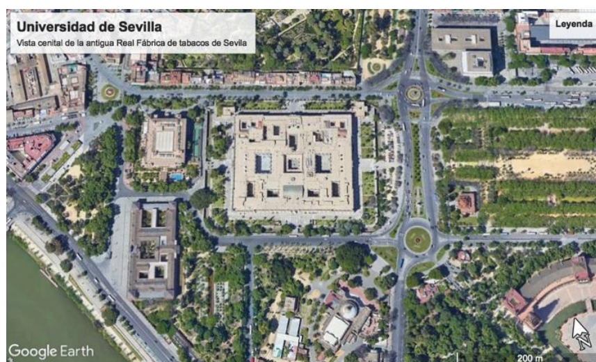
Figure 2: Vue aérienne de la Manufacture royale de tabac de Séville et de son environnement urbain 14
