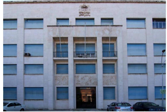
Figure 20: Façade principale de bâtiment administratif. Source: Service de l'urbanisme de la mairie de Séville, Service de l'urbanisme et du développement urbain: Catalogue de la Tabacaria Altadis . 2017.
