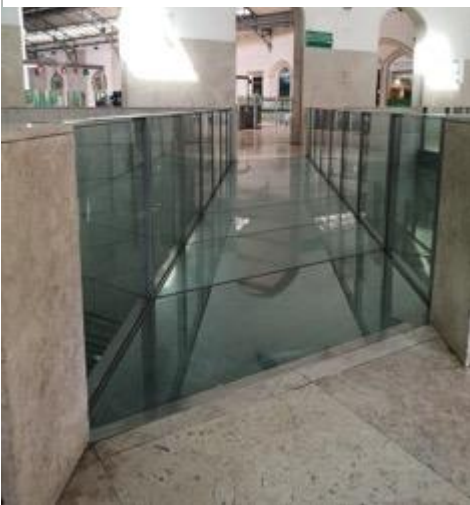
Figure 27 : Interieur de la Gare du Rossio. Source: Photo de Pablo Alonso González 2019.
