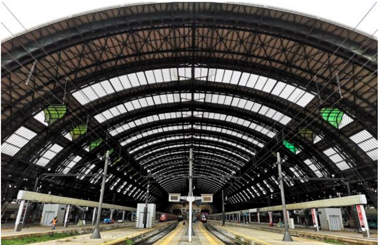
Figure 22: Vue générale des voies. Source: Photo de Pablo Alonso González 2019.
