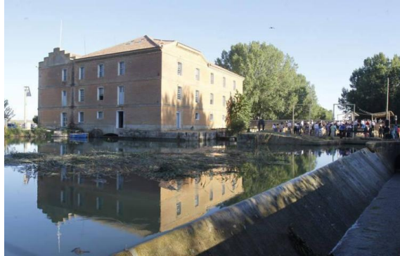
Figure 27: Vue depuis le canal de l'ancienne usine de farine à Abarca de Campos, Palencia. Source: El Norte de Castilla
