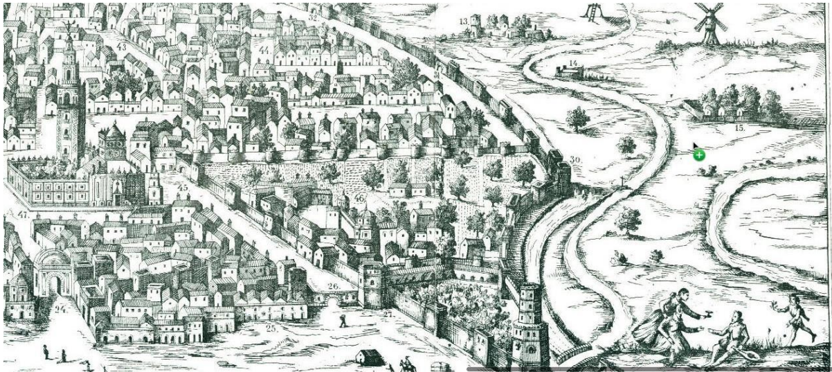
Figure 1: Dans cette miniature tirée du Cabinet des estampes de la Bibliothèque nationale, on peut voir le bord sud du mur sud avant la construction de l'usine (XV siècle). 10
