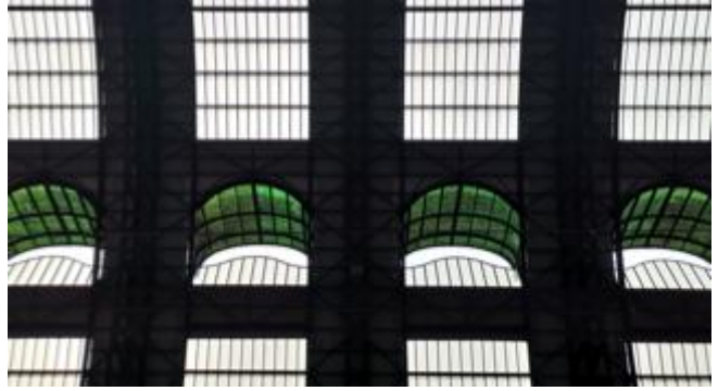
Figure 21: Détail du toit. Auteur de la photo : Pablo Alonso González.
