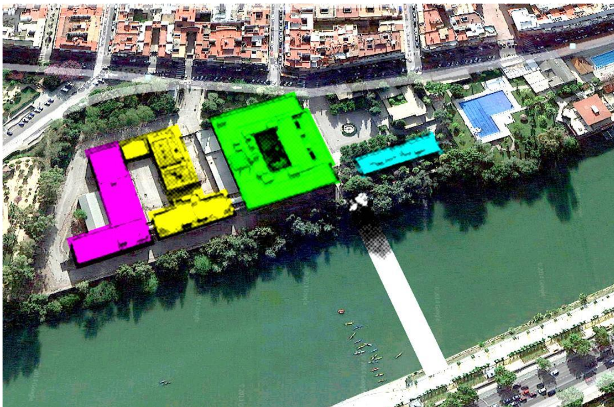
Figure 40 : les différents bâtiments qui signent l'ancienne usine de tabac regroupés par couleur selon leur fonction, à distinguer de gauche à droite : extension des entrepôts (rose), entrepôts primitifs (jaune), bâtiment de bureaux et d'ateliers (vert), habitations (bleu), éventuelle passerelle piétonne contemplée par la mairie (blanc). Source: Andalucía información 96 .
