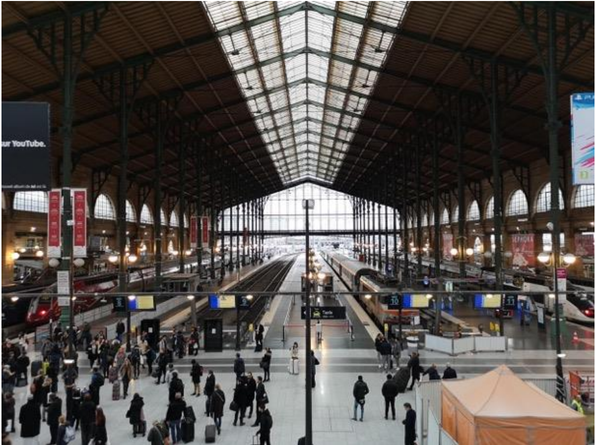
Figure 10 : A l'intérieur de la Gare du Nord, où les voies centrales et le toit à deux versants sont visibles. Source : Photo de Pablo Alonso González 2019.
