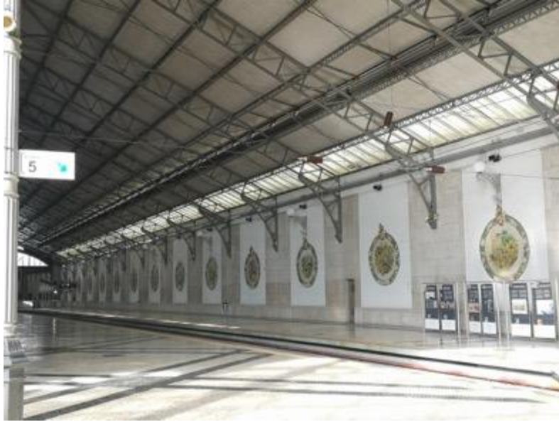
Figure 28. Intérieur de la Gare du Rossio . Source: Photo de Pablo Alonso González 2019.
