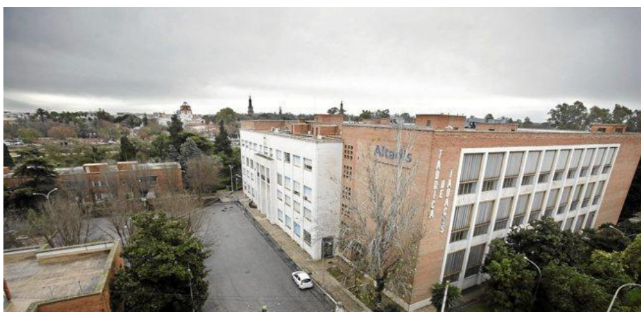
Figure 19 Vue de l'entrée principale du complexe d'Altadis (rue Sebastián Elcano) avec le bâtiment principal du complexe, celui dédié aux bureaux (en blanc), et les ateliers en brique. Source: Journal El Mundo (06-04-2014) https://www.elmundo.es/andalucia/2014/04/06/53414e38e2704e67088b4573.html
