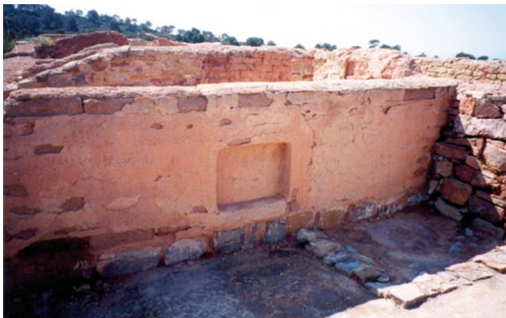
Figure 11. Élévation d'un mur en briques, contenant une niche, sur le site de Castellet de Bernabé (Llíria, Valence). III e s. av. n. è. (M. C. Belarte).
