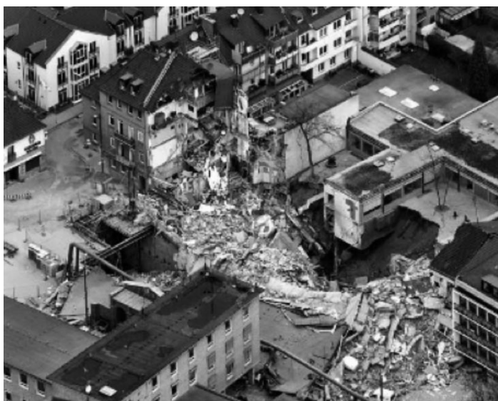
Le sinistre d'effondrement pendant le creusement du métro de Cologne illustre les enjeux de couverture.
