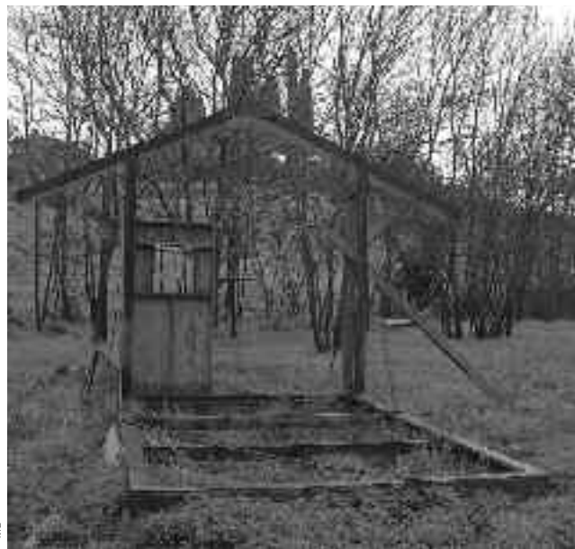
Ossature bois préfabriquée, pour le logement de jeunes agriculteurs..
