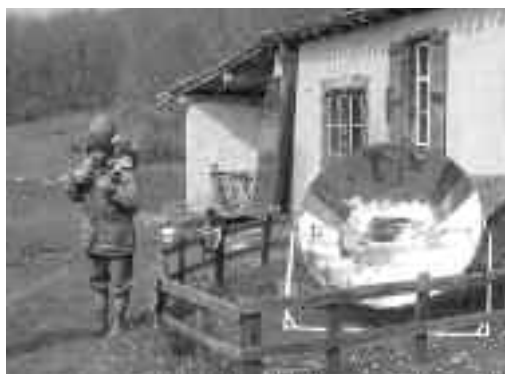
Chauffe-eau solaire, devant la maison principale.
