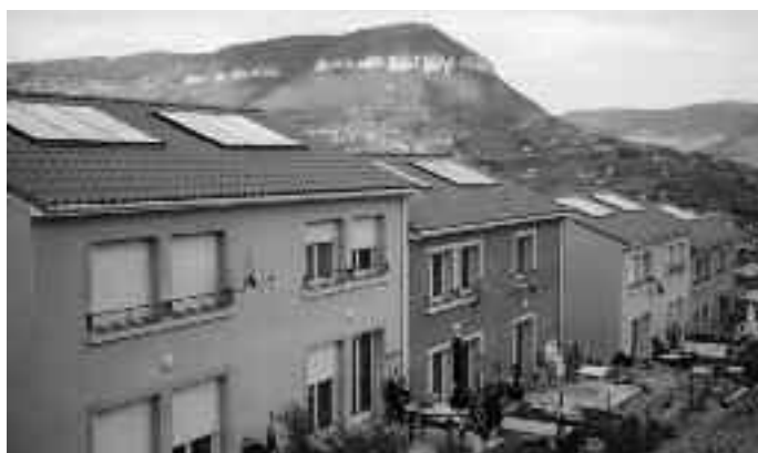
Réduction des dépenses d'énergie dans des logements sociaux de Millau (Aveyron) par la pose de chauffe-eau solaires.
