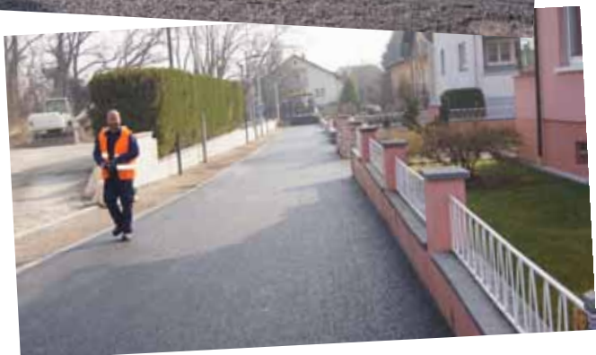
Travaux d'enrobés rue des Jardins
