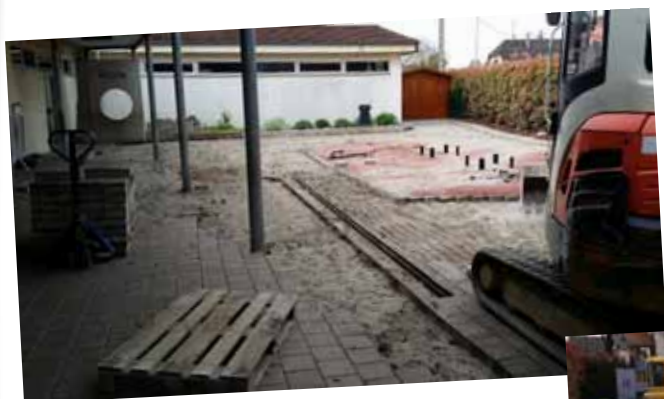
Travaux de réfection de la cour de l'école maternelle
