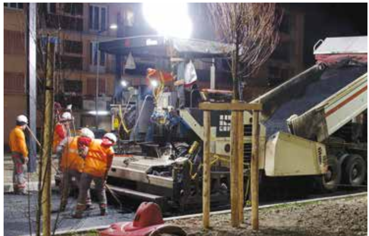
Des travaux nocturnes nécessaires
