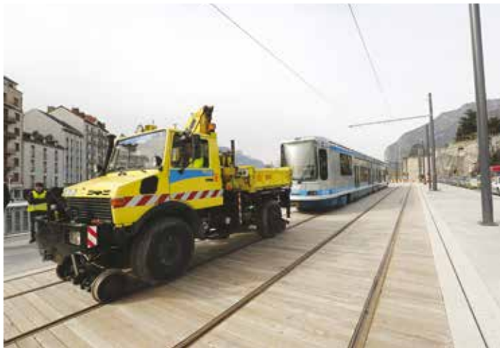
Premiers essais sur le tronçon sud de la ligne E (archives)
