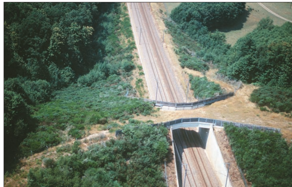
Exemple de passage pour la grande faune
