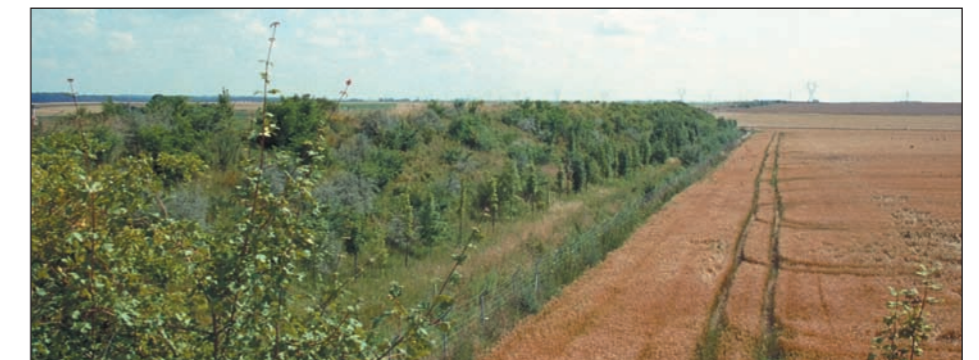
Exemple de merlon de protection acoustique sur la LGV Nord Source : Réseau Ferré de France, 2000.
