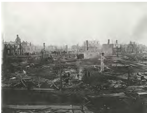
Quartier Saint-Sauveur - Incendie - mai 1889.
