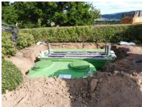
Filtre à massif de zéolithe
