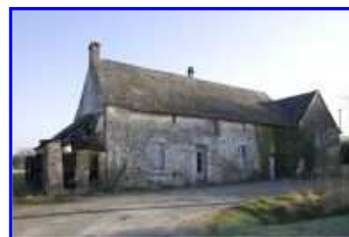
Logis, vue de trois-quarts vers l'est.
