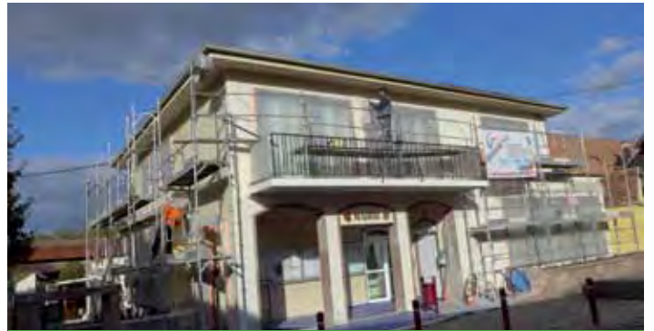
pose d'un filet de protection et d'une sous couche début novembre
