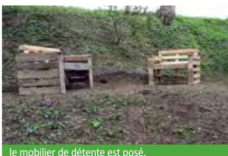
le mobilier de détente est posé.
