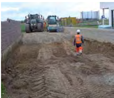
Création d'une nouvelle voirie rue du Mandelberg, avec la pose de deux avaloirs pour les eaux pluviales.
