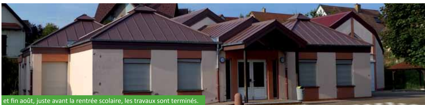
En été aussi, les agents communaux ont repeint les murs des deux salles de classe de l'école maternelle,
