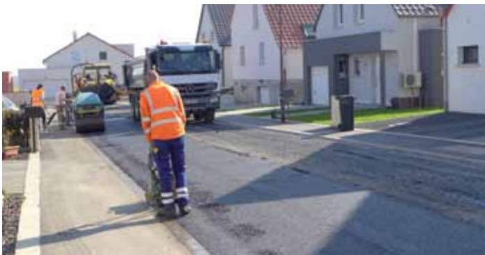
Travaux de finition rue du Grand Hallier...
