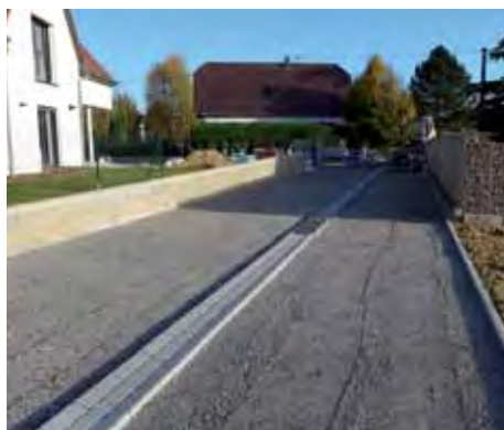
Création d'une nouvelle voirie rue du Mandelberg, avec la pose de deux avaloirs pour les eaux pluviales.
