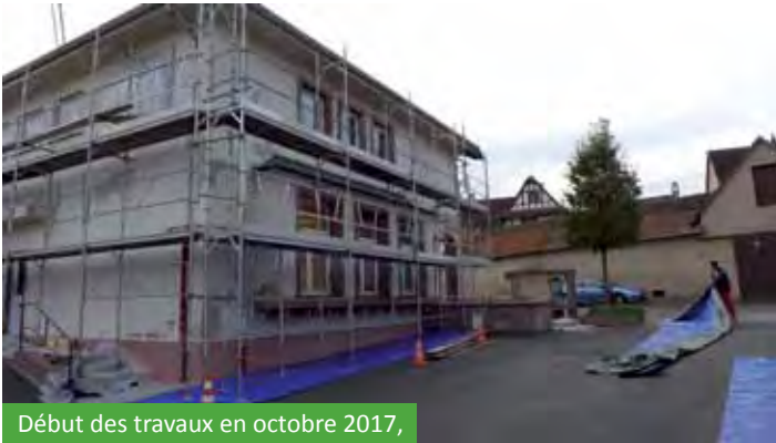
pose d'un filet de protection et d'une sous couche début novembre
