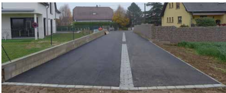
Création d'une nouvelle voirie rue du Mandelberg, avec la pose de deux avaloirs pour les eaux pluviales.
