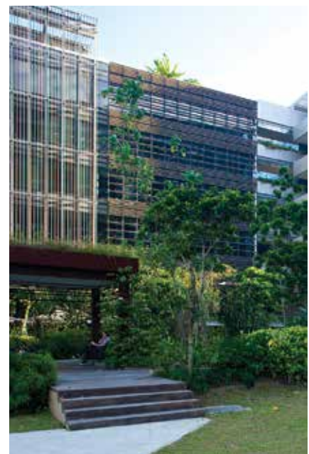
Au-dessus: L'hôpital Khoo Teck Puat à Singapour des Architectes RmJm se sert de l'air frais et de la lumière du soleil pour améliorer le confort thermique. Image © Jui-Yong Sim/Flickr
