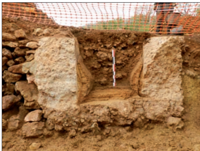
Figure A.54b. Dépôts carbonatés dans l'aqueduc gallo-romain de Poitiers (Photo : J. Brenot, Evéha, fouilles 2013).
