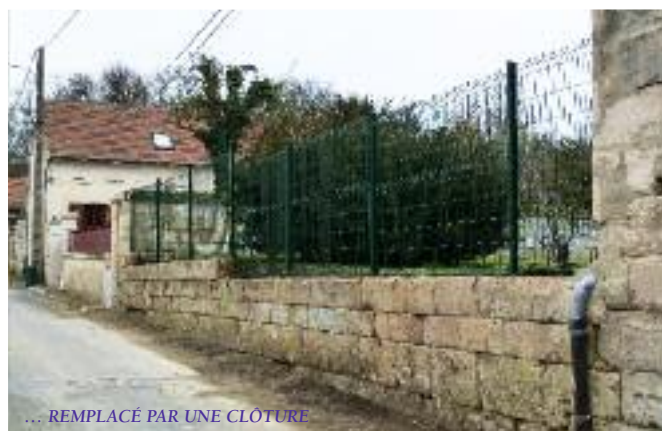
... REMPLACÉ PAR UNE CLOTURE
