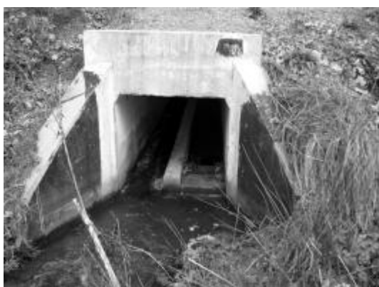
Photos 16 et 17 : Ce passage, insuffisamment calé à la cote de crue requise (Q5 ou Q10), est inondé à l'aval par conditions hydrauliques courantes et de ce fait rendu inopérant pour la loutre ou la petite faune (photo L. Lafontaine).
