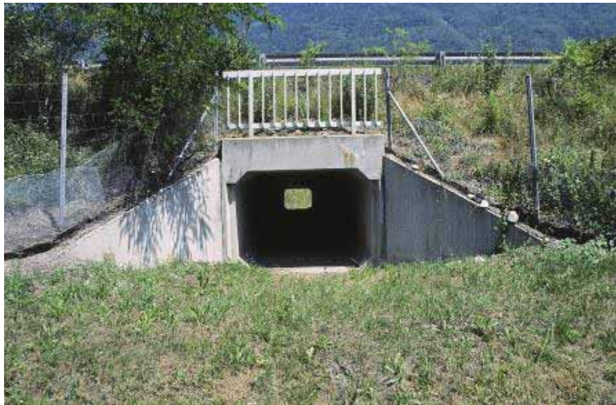
Cadre fermé, largeur : 2 m, hauteur : 1,50 m, longueur : 26 m
