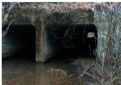
Photo 6 : Ouvrage du vallon de l'étang des Tartres
