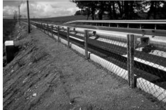
Photos 21 et 22 : Deux exemples français de dispositifs destinés à interdire aux loutres l'accès à la chaussée : en grillages bas (RD 8, Côtes d'Armor) ou palissades en bois (RD 773, Loire Atlantique), fixés en arrière des glissières de sécurité. (photos L. Lafontaine et PNR de Brière).
