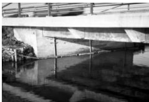
Photos 7 et 8 : Ouvrages aménagés au Danemark : berges reconstituées ou banquette flottante (photos O. Korbel).
