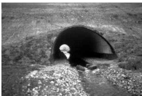
Photos 7 et 8 : Ouvrages aménagés au Danemark : berges reconstituées ou banquette flottante (photos O. Korbel).
