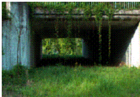
Photo 2 : Ouvrage grande faune de la Mangerie
