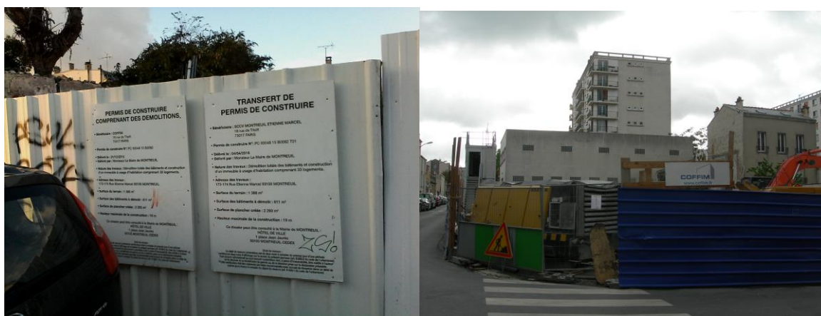
Montreuil 2016 – futur collectif de logements réalisé par un groupe régional
