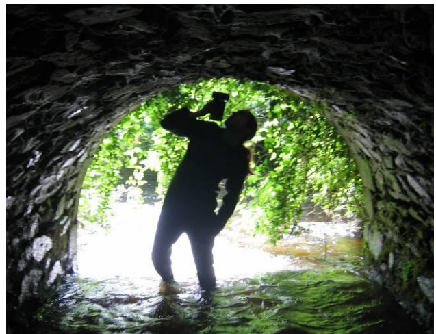
Recherche de chauves-souris sous un pont
