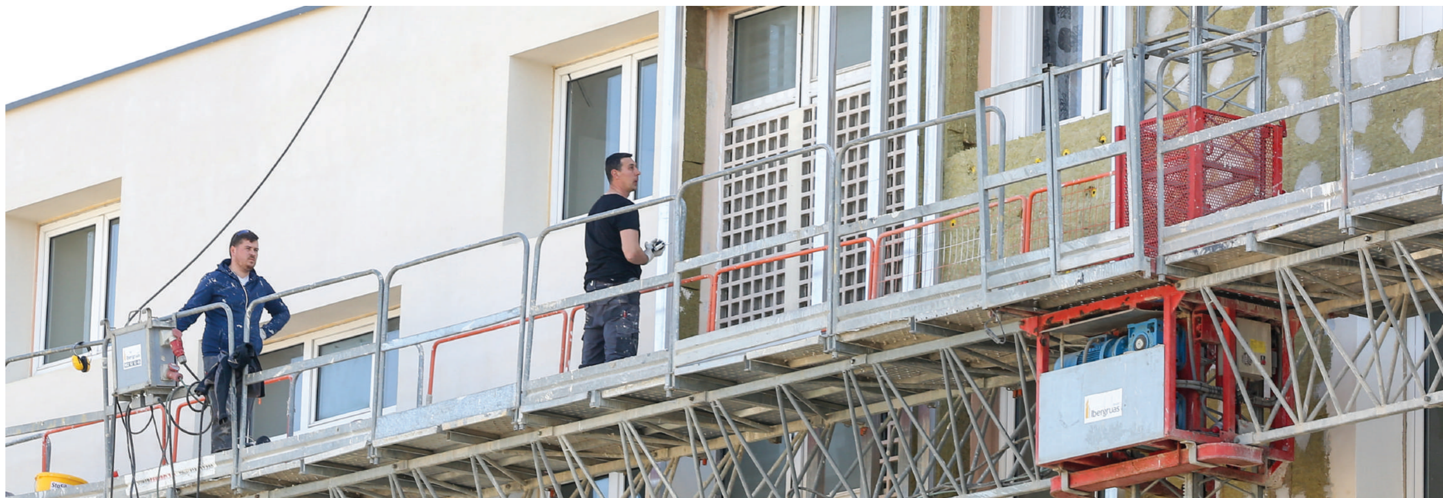
Travaux d'isolement par l'extérieur - Opération « Marin la Meslée » à Tours
