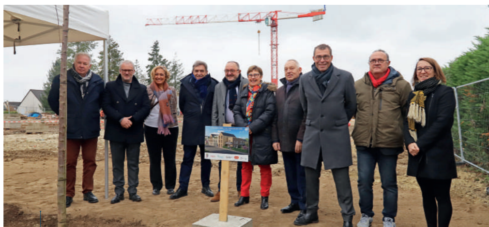
Pose de première pierre sur l'opération « Les Terrasses du Cher » à Azay-sur-Cher
