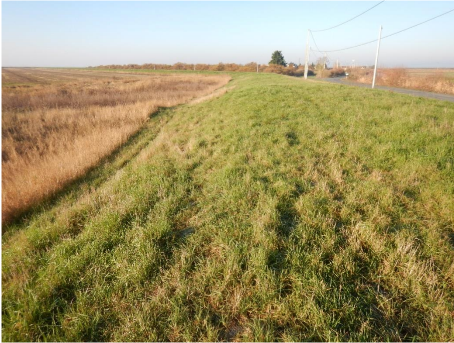
Figure 54. Vue du remblai actuel sur lequel la digue viendra s'implanter
