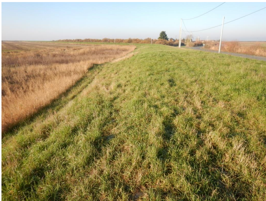
Figure 64. Vue du remblai actuel sur lequel la digue viendra s'implanter
