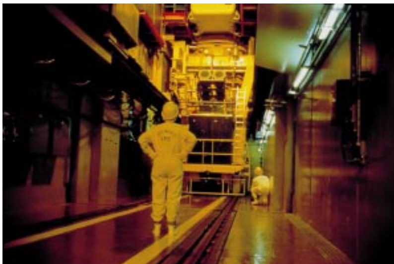
Déchargement des combustibles usés du réacteur Superphénix
