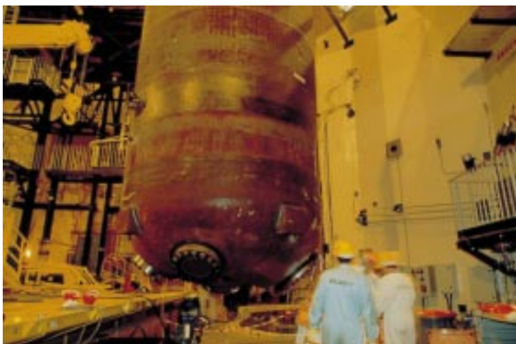
Remplacement d'un générateur de vapeur à la centrale nucléaire du Bugey
