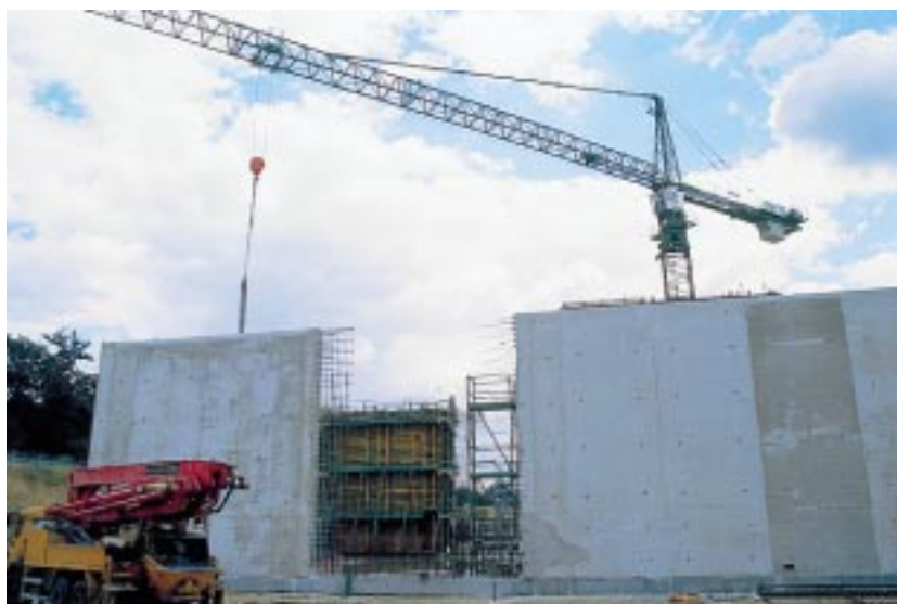
Centre de l'Aube construction des ouvrages de stockage, tranche IV
