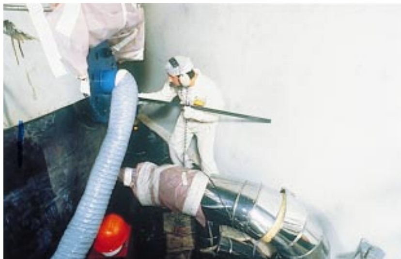
Contrôle d'un tube de générateur de vapeur
