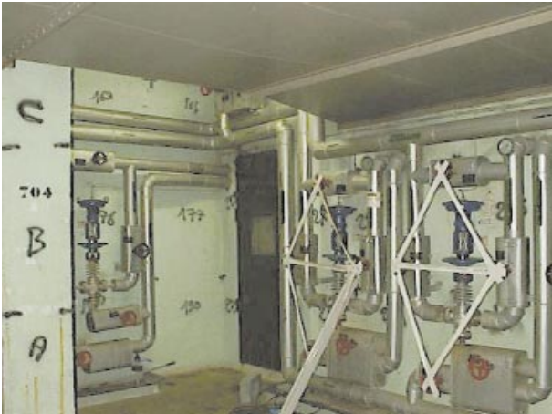
Atelier AT1 de La Hague – Vue avant assainissement
