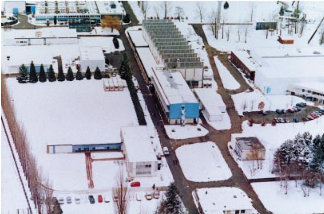
Installation SICN de Veurey-Voroize
