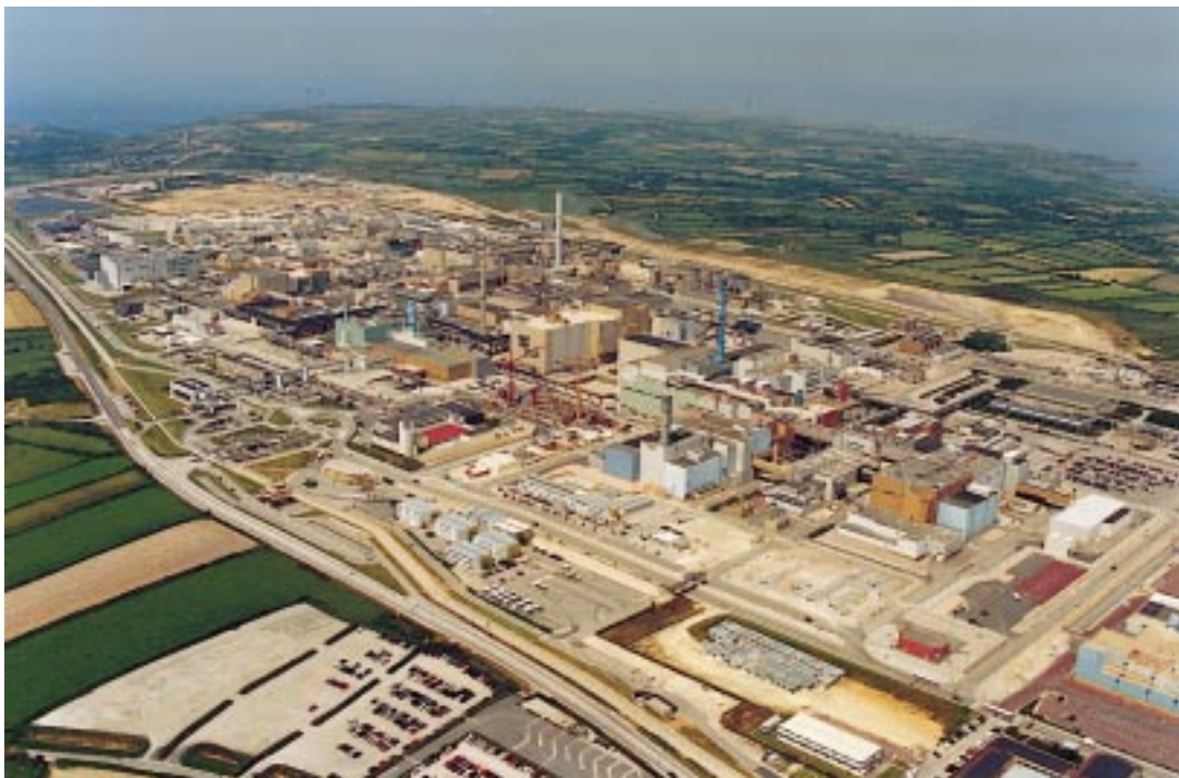
Etablissement COGEMA de La Hague
