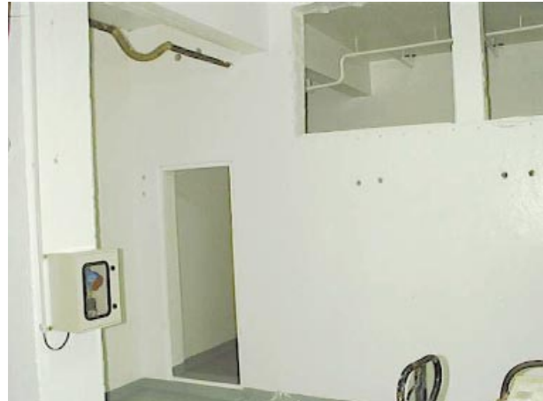
Atelier AT1 de La Hague – Vue après assainissement
