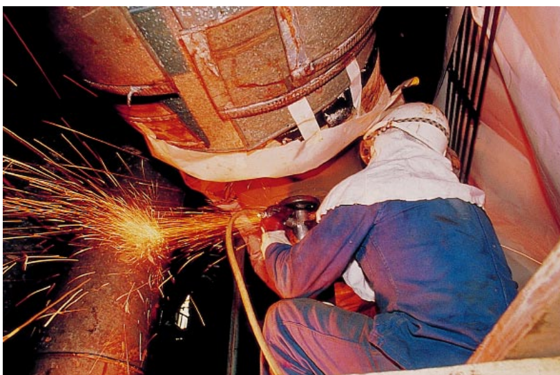
Intervention sur une canalisation lors d'un arrêt de tranche
