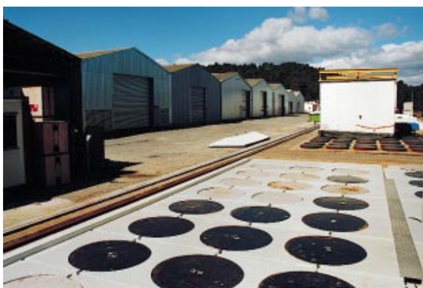
Centre CEA de Cadarache Parc d'entreposage des déchets (INB 56)
