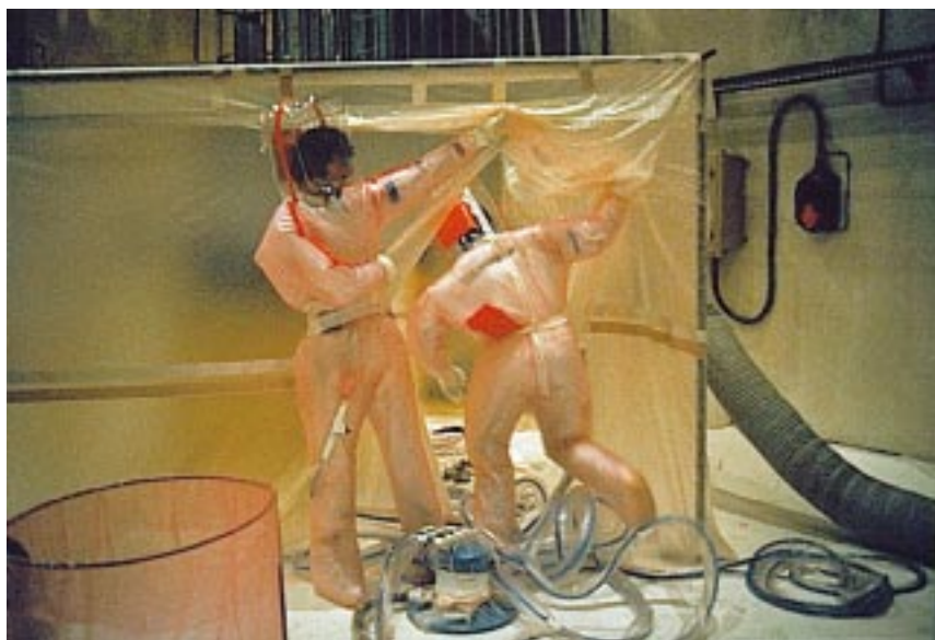
Intervention lors d'un arrêt de réacteur
