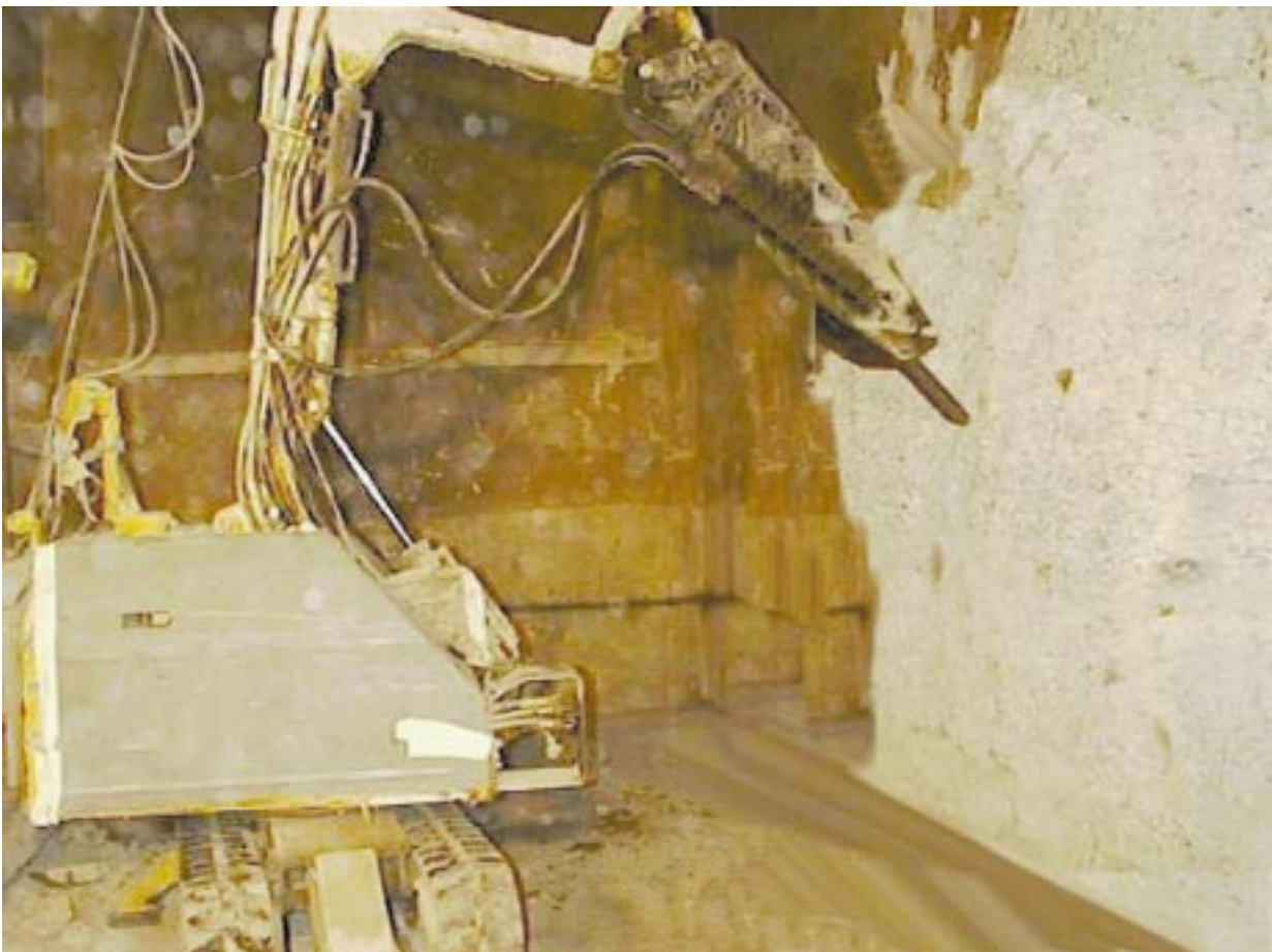
Atelier AT1 de La Hague : écroutage
