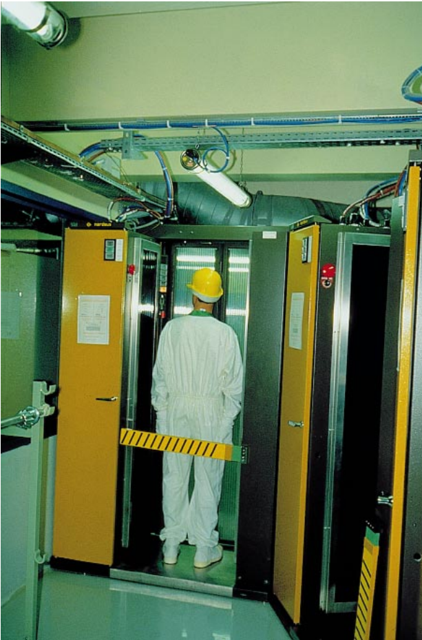
Contrôle de l'absence de contamination du personnel en sortie de zone contrôlée
