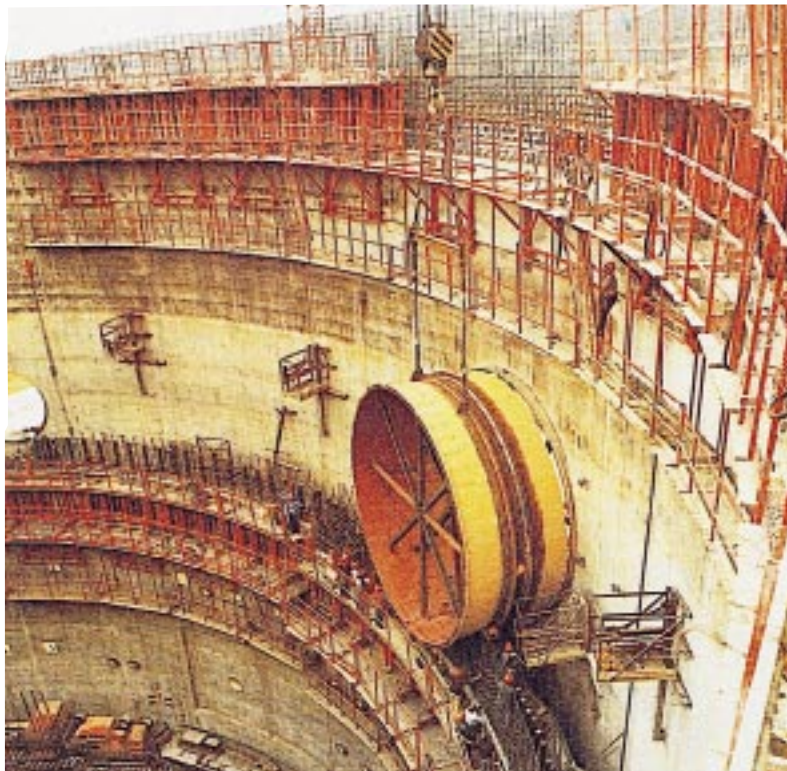
Enceinte à double paroi en cours de construction avec mise en place de l'accès matériel (tampon)
