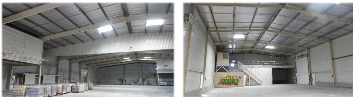
Vues internes des bâtiments industriels à ossature métallique présents sur l'aire d'étude (sur site)
