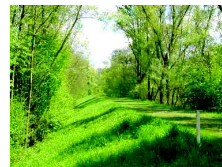
Digue Nord du Canal d'alimentation de l'III. Elle marque la limite Sud-Ouest du polder d'Erstein
