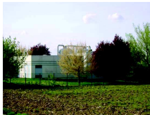
Captage d'eau par forage du Negerdorf, au Sud-Ouest d'Erstein
