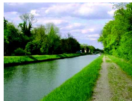
Un linéaire totalement artificialisé : bas de berges stabilisées par des palplanches et absence totale de ripisylve
