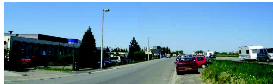
Section sud de la Rue de l'Expansion – véhicules en stationnement + trafic important sur la RD 1083
