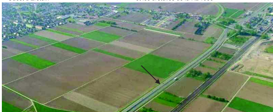
Le tracé rectiligne de la RD1083 traversant le paysage ouvert de la terrasse agricole d'Erstein
