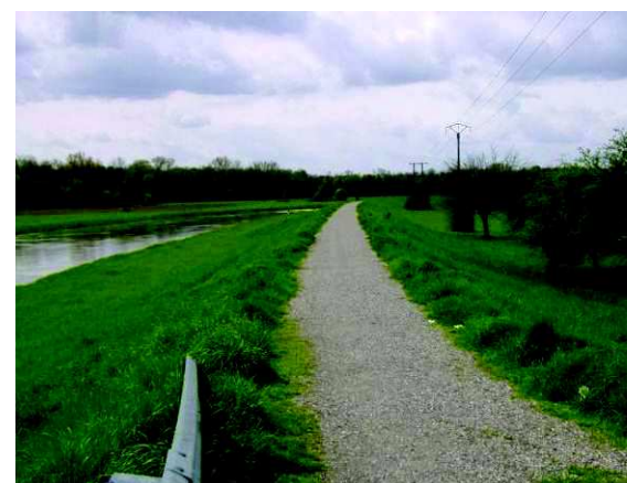
Digue Nord longeant le canal de décharge de l'ill et constituant la limite de la zone inondable définie par arrêté préfectoral du 14 septembre 1983
