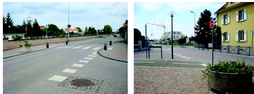
Aménagement de certaines intersections par un pavage différencié
