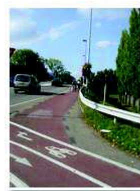
Franchissement cyclable (et routier) de la RD 1083
