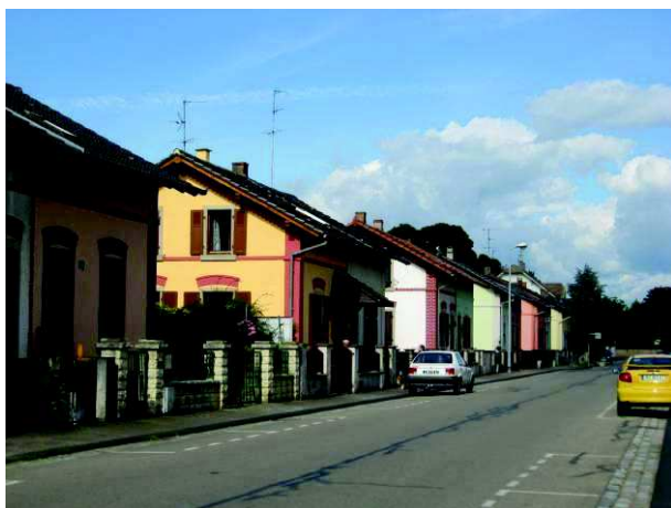
Les maisons accolées de la Rue du Général Leclerc
