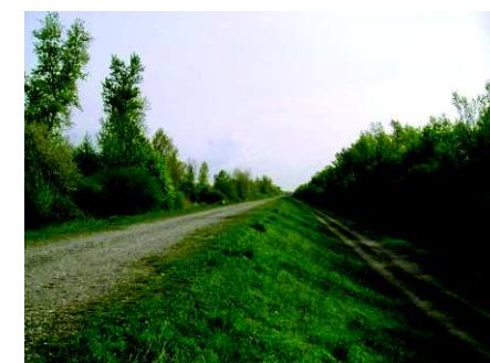
Digue Est du bassin de compensation de Plobsheim
