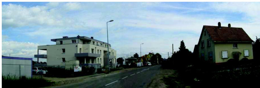
Collectif en construction en bordure de la Rue du Général de Lattre de Tassigny
