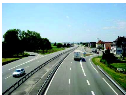
La RD 1083, axe majeur de la commune, au niveau de l'échangeur de l'entrée Ouest d'Erstein
