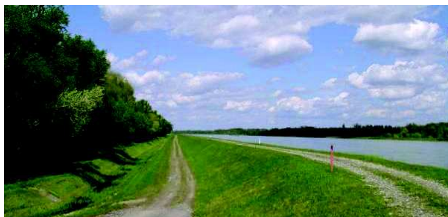
Le Rhin canalisé à l'intérieur de ces digues, séparant artificiellement le fleuve des forêts alluviales.
