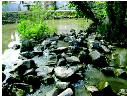
Enrochements servant de point de passage pour les promeneurs entre l'île du Brunnenwoerth et l'île du Schlossdichel
