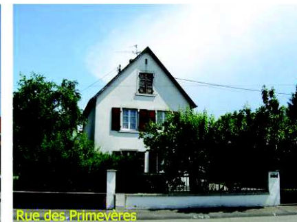
Rue des Primeveres
