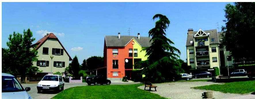
Krafft – Rue des Aubépines – Un épanelage dégressif
