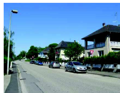
Maisons d'habitation au nord de la rue de l'Expansion
