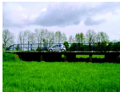
Exemple d'aménagement permettant d'atténuer la coupure physique d'un corridor écologique, générée par un remblai routier au cœur du Ried
