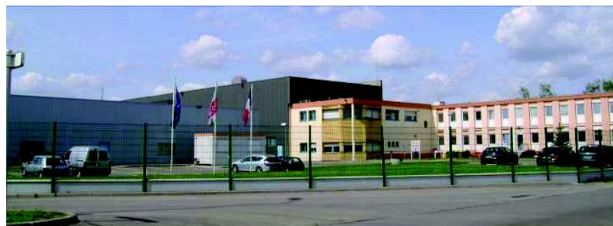
Installations de l'entreprise DOW France
