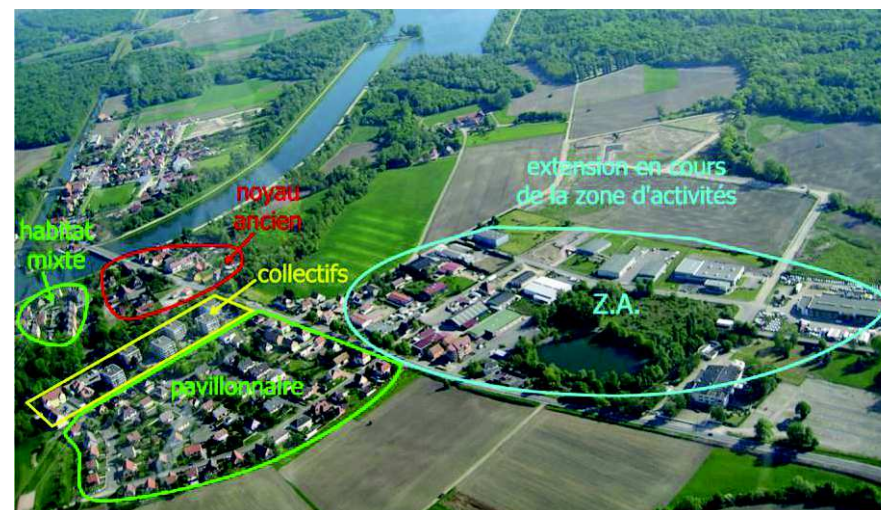
Krafft – Organisation du bâti – entrée sud
