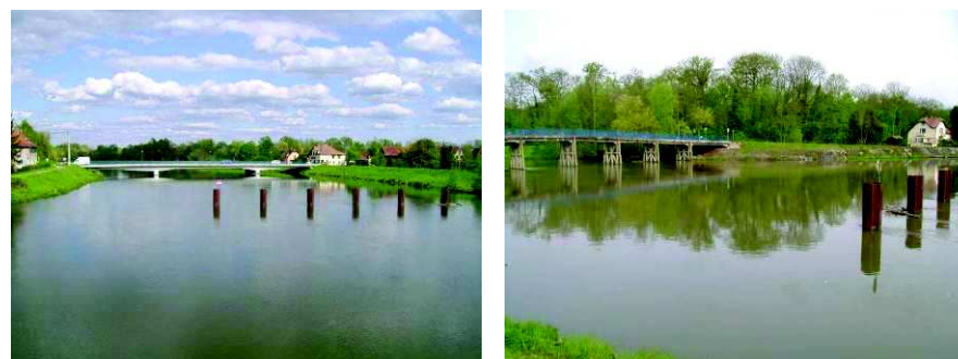
Nœud fluvial entre le canal de Décharge de l'Ill et le Canal du Rhône au Rhin, situé au cœur de Krafft : un espace spectaculaire, mais dont les abords sont peu mis en valeur
