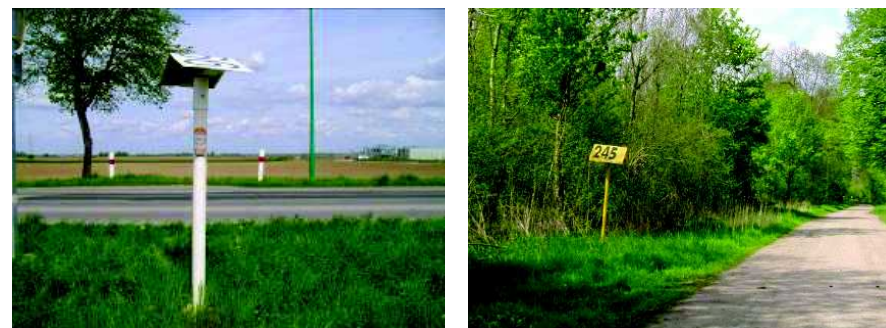
Bornes signalant le passage d'un pipeline (à gauche) et d'un gazoduc (à droite)
