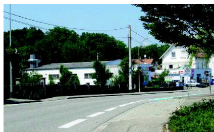
Rue Saint-Quentin (D 468) – Garage Eurorepar
