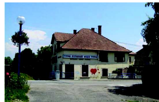
Krafft – Ancien restaurant actuellement dégradé
