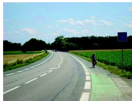
Bande cyclable le long de la RD 426 entre Erstein et Krafft
