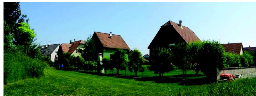
Arrière de la rue des Lilas – Clôtures végétales arbustives
