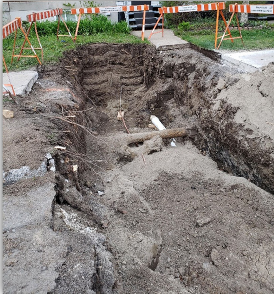
Figure 5 - Travaux de remplacement d'un branchement de service sur l'emprise municipale
