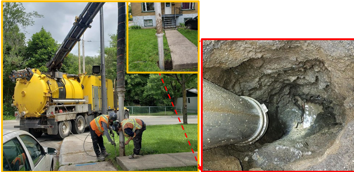
Figure 2 - Caractérisation d'un branchement de service par hydro-excavation
