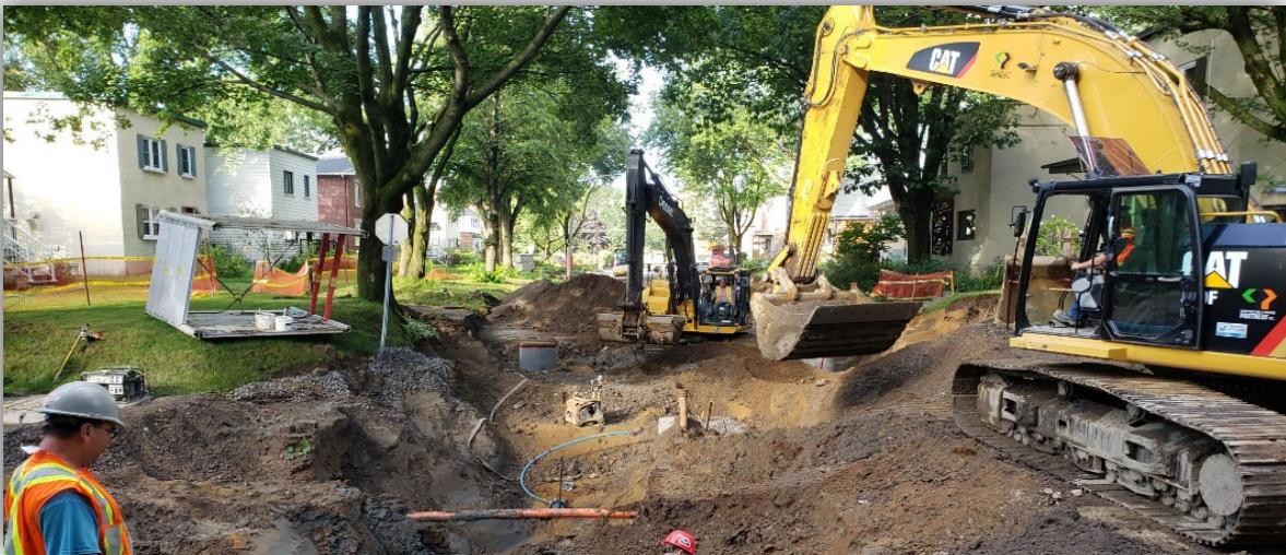
Figure 6 - Remplacement d'un branchement de service lors de travaux planifiés
