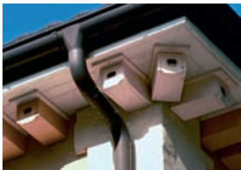
Les nichoirs destinés au Martinet noir aident à préserver les sites de nidification. Ils sont fixés contre la façade ou intégrés dans la construction.
