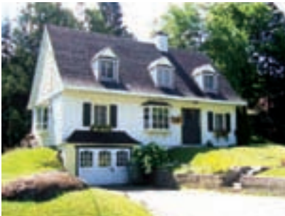
20 Maison à lucarnes, 10, Hébert
