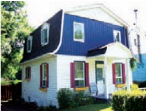
21 House with a modern mansard roof, 101, de l'Église (around 2000)
