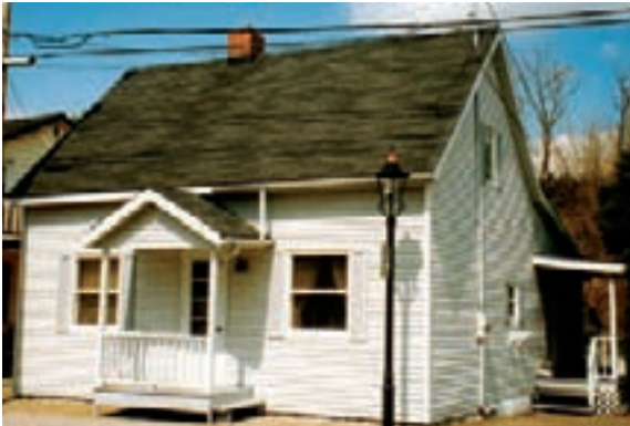
5 Bedeaux House, 17 de l'Église
