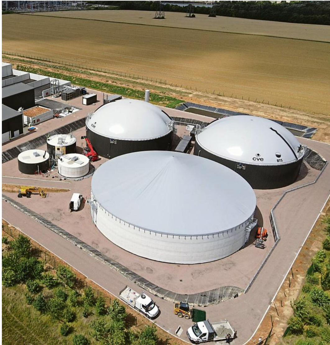
12.500 tonnes de biodéchets seront revalorisés chaque année dans l'usine Equimeth. Photo CVE
